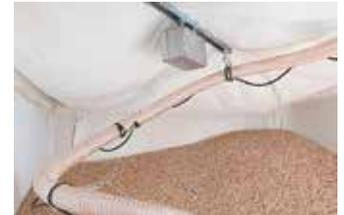
Der **HDG Pellet-Maulwurf** ist ein Lagerentnahmesystem für Pelletkessel mit Saugsystem. Er ist für den Einsatz in Kombination mit dem Pelletkessel HDG K10-63 geeignet.
