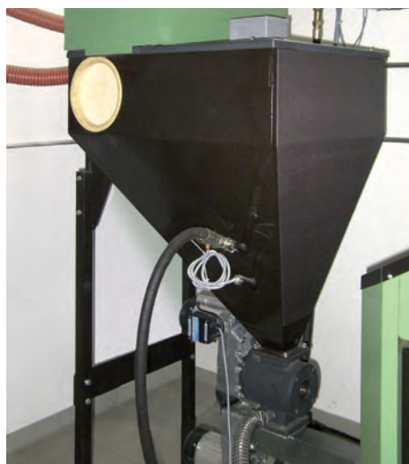
Le conteneur à aspiration du système d'aspiration des granulés HDG recueille jusqu'à 100 kg de granulés.
