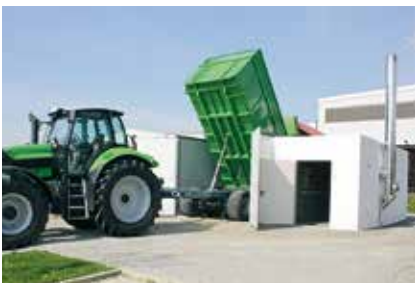
Befüllen des Brennstofflagers.
