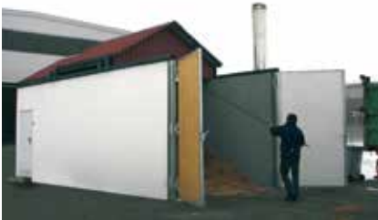
Aufschieben des Daches des Brennstofflagers.
