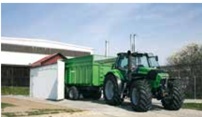
Befahren des Schubbodens.
