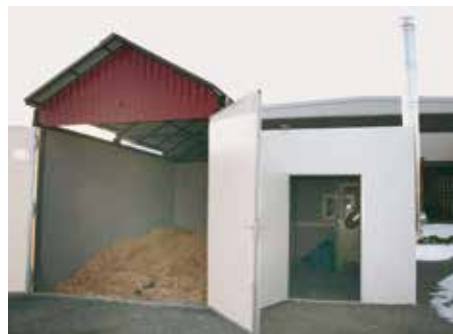
Schließen des Daches des Brennstofflagers.
