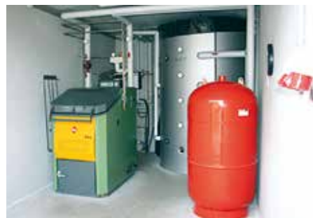
Gut zugänglich und aufgeräumt – so präsentiert sich die HDG Heizbox für Scheitholzkessel.
