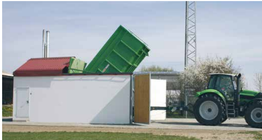
Aufschieben des Daches des Brennstofflagers.
