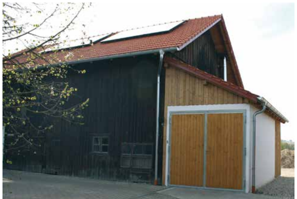
... darauf die HDG Heizbox – und fertig.
