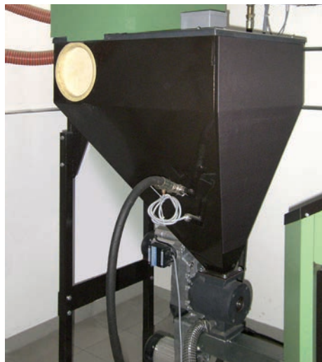
Il serbatoio intermedio del sistema di aspiro pellet HDG raccoglie fino a 100 kg di pellet.
