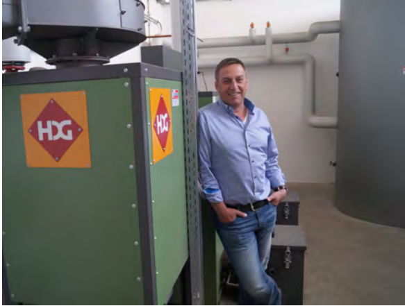
Das Forst-Kompetenzzentrum der Firma Unterreiner im niederbayerischen Buch wird von einer HDG Compact 150 beheizt.
