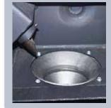
Die **vollautomatische Aschenaustragung** der Verbrennungs- und Flugasche sorgt für lange Betreuungsintervalle. Die Ansteuerung der Flugraumentaschung ist mit der Abreinigung der stehenden Wärmetauscherflächen gekoppelt.
